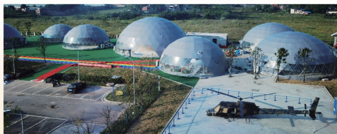
航空科普研学基地主体完工
