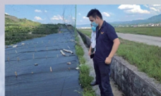
青年突击队认真查验跑道、排水沟等基础设施
