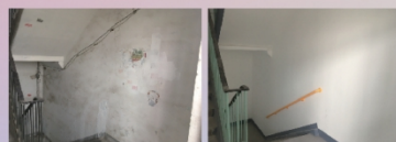
团结湖北里5号楼楼梯间改造前后对比图
